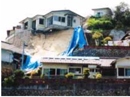
写真1 芸予地震後の宅地の崩壊 (呉市両城2-18地区)
