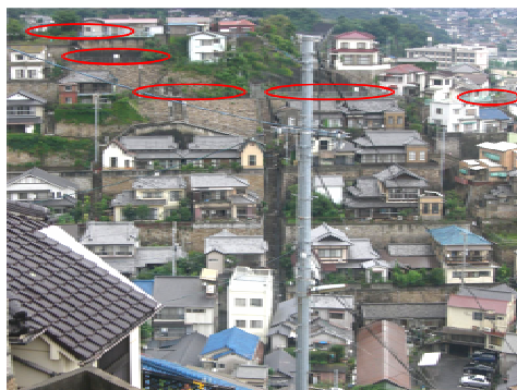
写真5 事業の跡地が点在する呉市両城地区
